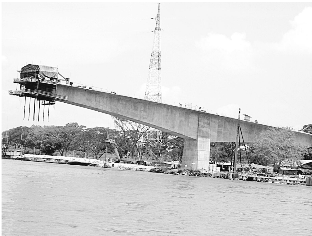
La construcción del puente Barrancabermeja-Yondó, alterará los circuitos económicos de la mayoría de los productos que entran y salen de la región.
