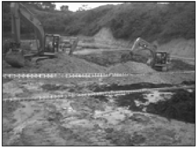
Retroexcavadoras retirando lodos.
